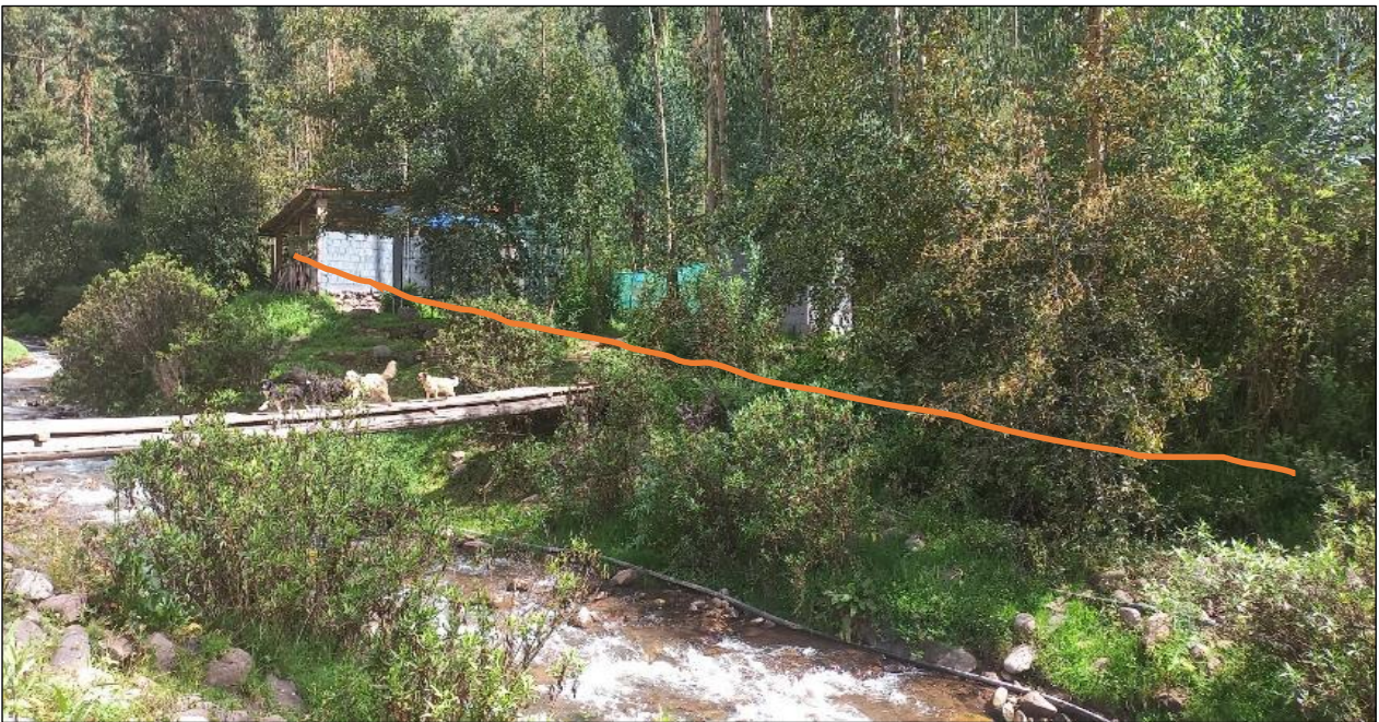
FOTOGRAFIA N°01: TRAMO DE INTERVENCION CON ENROCADO EN LA MARGEN IZQUIERDA DEL RIO LUCRE, EXISTE RIESGO DE DESBORDE DEL RIO.
